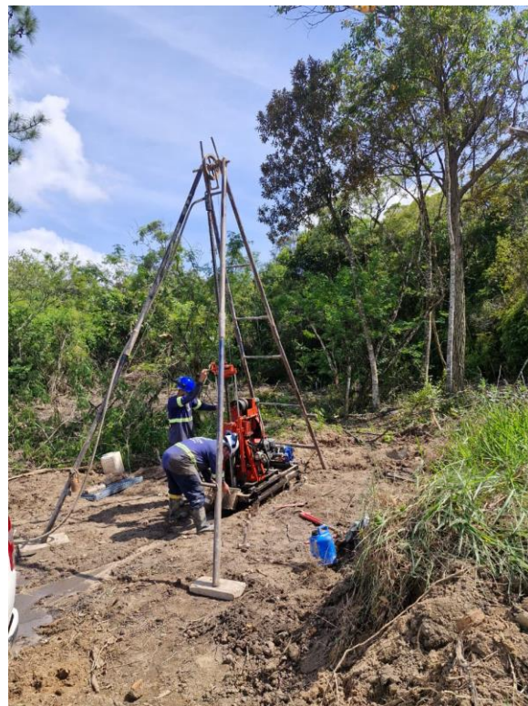
Figura 2 – Imagens demonstrando e execução do método de sondagem rotativo.
