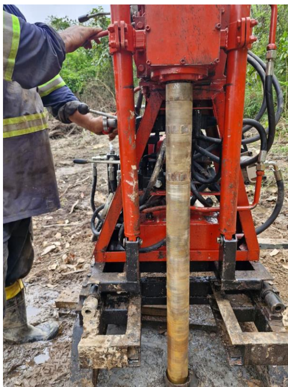
Figura 3 – Imagens demonstrando e execução do método de sondagem rotativo.
