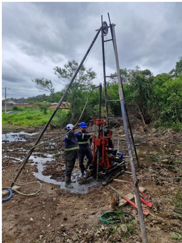
Figura 2 – Imagens demonstrando e execução do método de sondagem rotativo.
